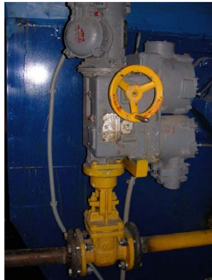
Рис. 12. Паровая задвижка
